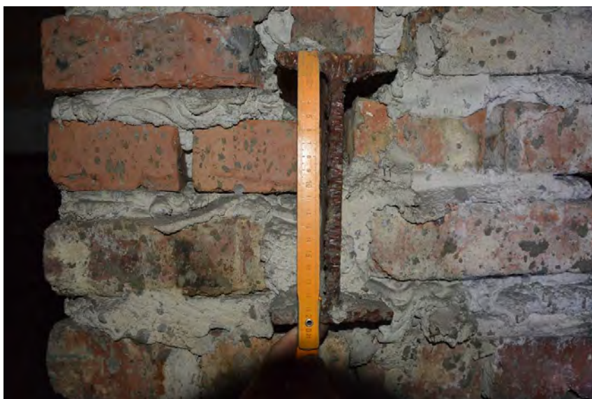
Rys. 14. Pomiar wysokości belki stalowej w części środkowej. [1.3]
