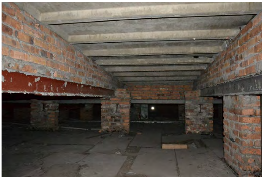
Rys. 10. Dach widok od dołu. [1.3]
