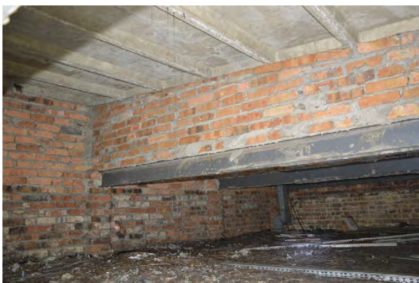
Rys. 9. Dach widok od dołu. [1.3]
