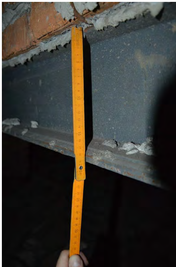
Rys. 13. Pomiar wysokości belki stalowej z nakładką w części zewnętrznej. [1.3]
