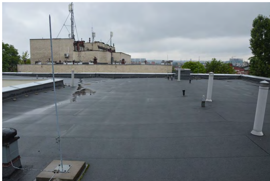
Rys. 19. Widok dachu budynku B część wschodnia.
