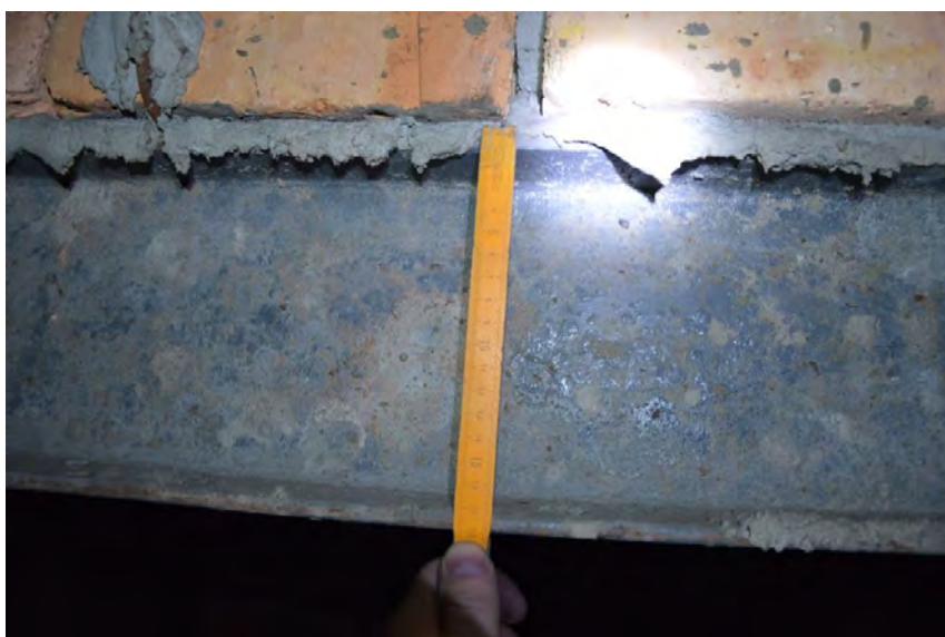
Rys. 12. Pomiar wysokości belki stalowej w części zewnętrznej. [1.3]
