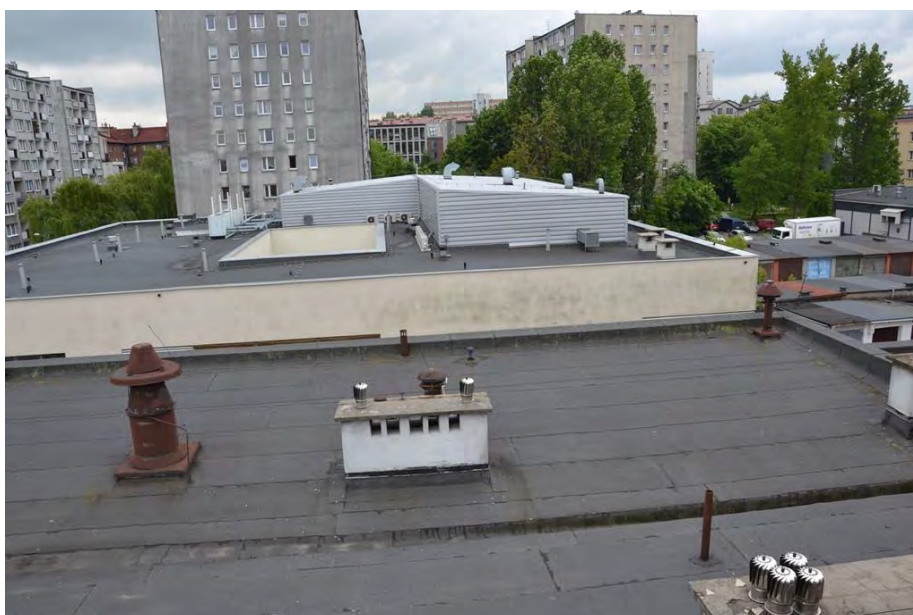
Rys. 17. Widok dachu budynku B.
