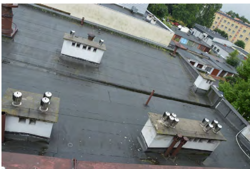
Rys. 8. fragmentu budynku A. [1.3]
