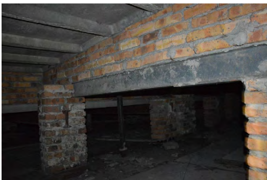
Rys. 11. Dach widok od dołu. [1.3]
