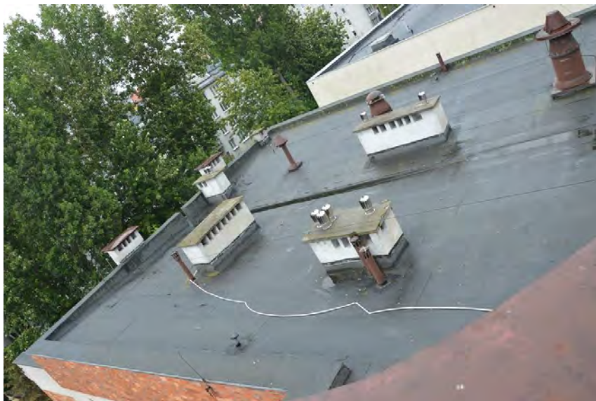
Rys. 7. Dach fragmentu budynku A. [1.3]
